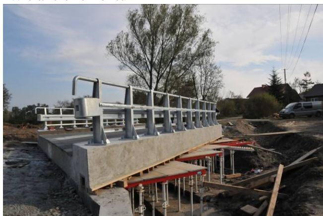
W trakcie remontu
