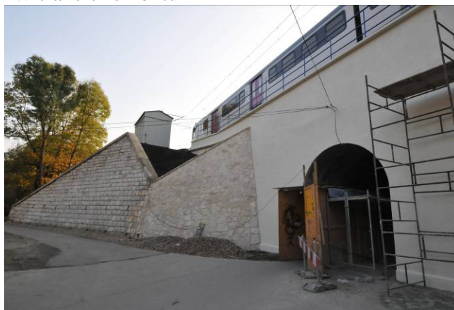
W trakcie remontu
